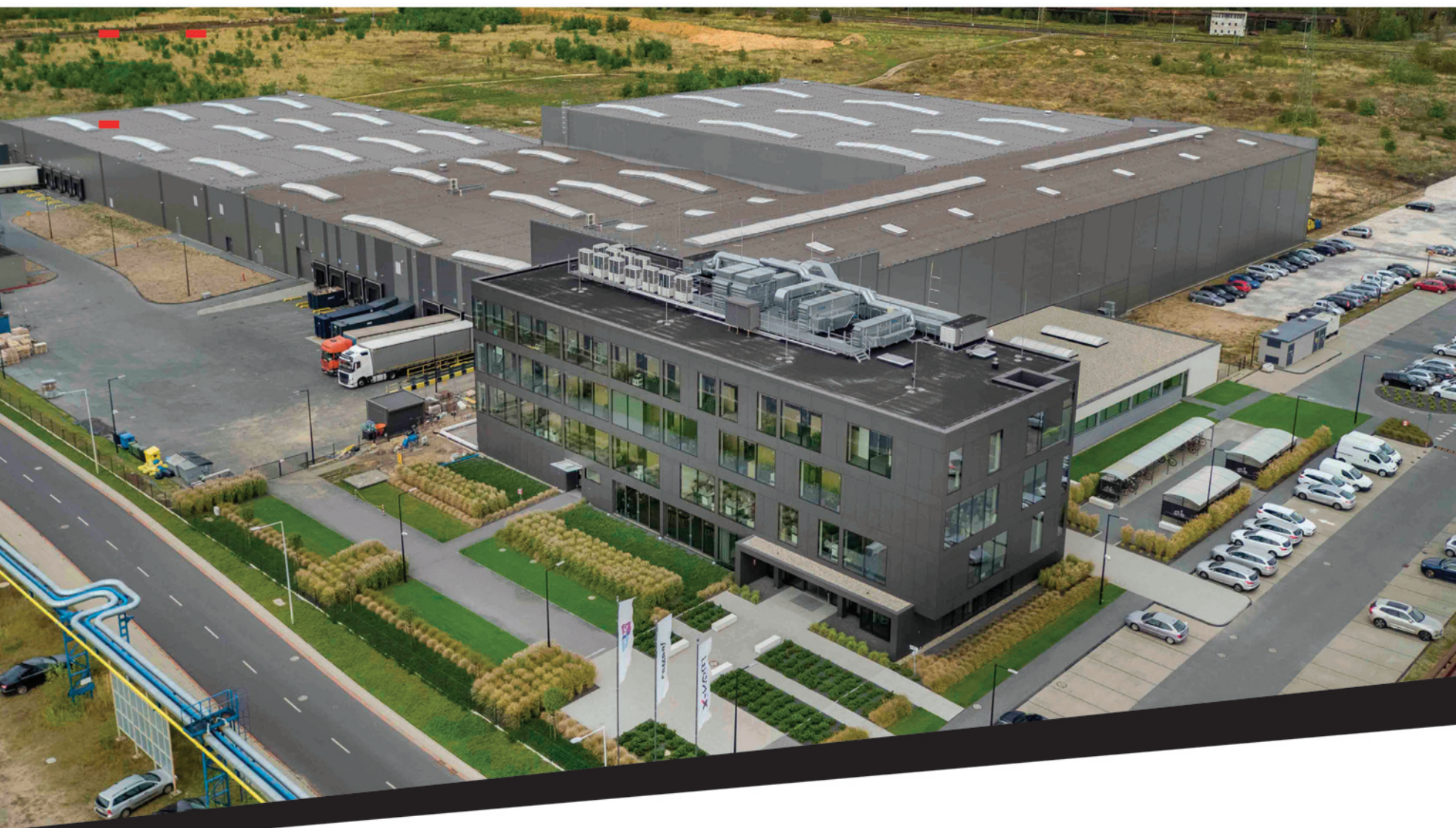
Hala magazynowa, budynek biurowo-produkcyjny, pompownia, X-Kom (Częstochowa)
